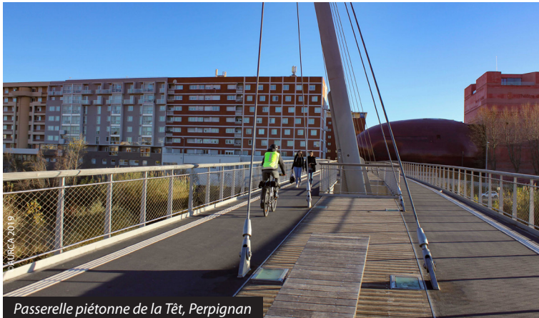
Passerelle piétonne de la Têt, Perpignan
