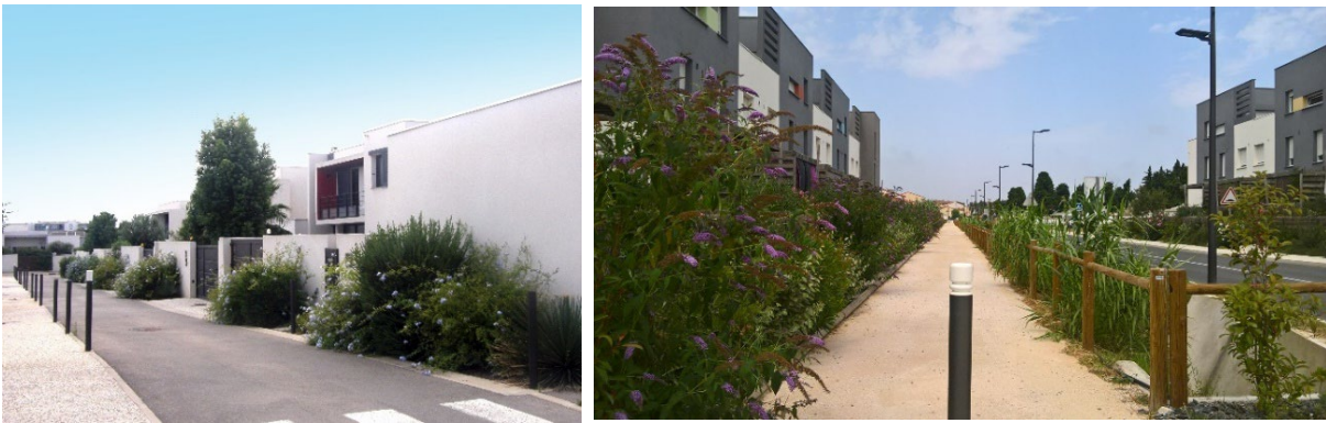
Figure 104 : De gauche à droite : végétalisation au pied des façades du Quartier Saint-Pierre à Perpignan / Traitement paysager et sécurisé de l'espace public du nouveau quartier « L'Era » en entrée de ville à Saint-Nazaire (AURCA)
