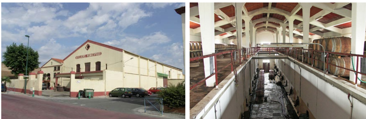
Figure 91 : De gauche à droite : cave coopérative de Bompas et structure en béton armé de la cave de Montner (AURCA)
