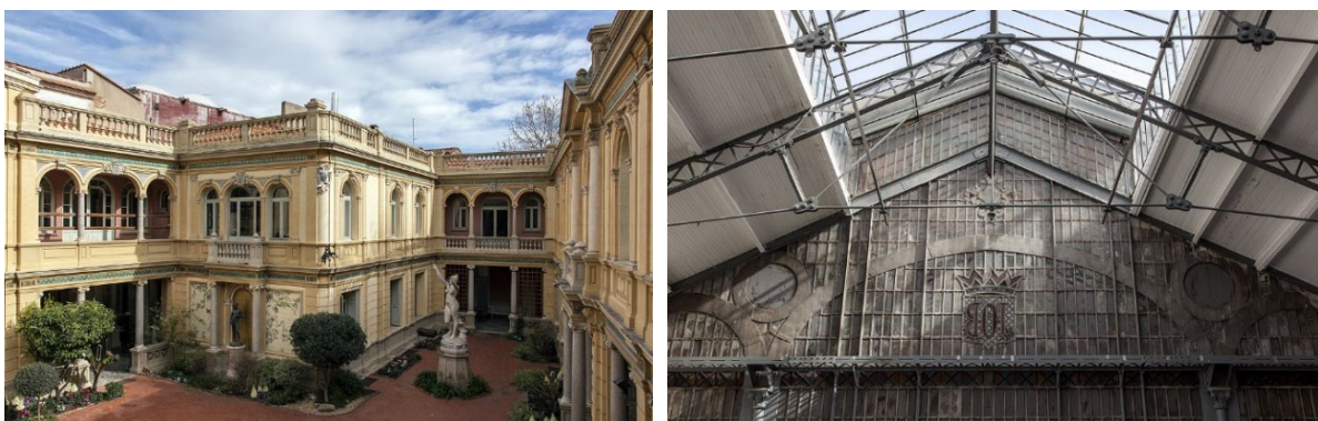
Figure 90 : Hôtel Pams, ancienne manufacture JOB à Perpignan (crédits Laurent Besson photographe)
