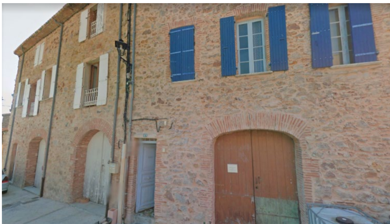
Figure 71 : Maisons vigneronnes à Calce (source Google) (AURCA)
