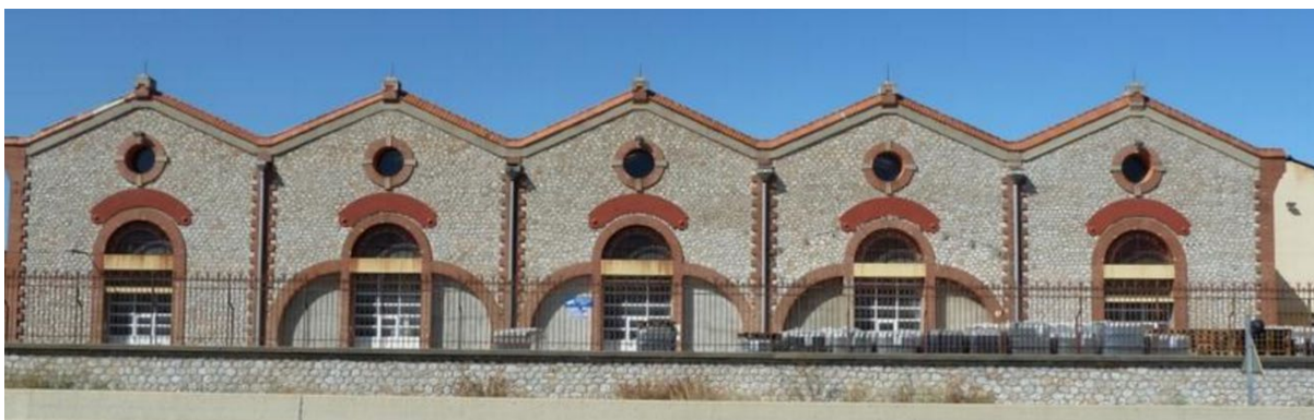
Figure 92 : Ancienne cave coopérative Byrrh à Rivesaltes (labélisée patrimoine du XX ème siècle) (AURCA)
