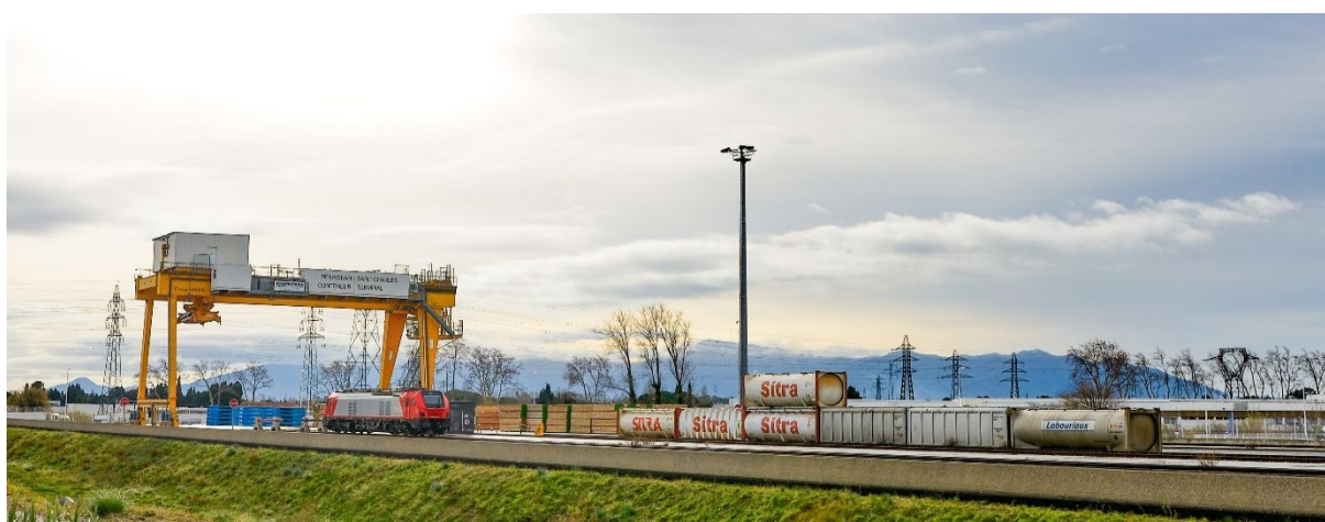
Figure 45 : Chantier combiné Marché St Charles – Perpignan (AURCA)
