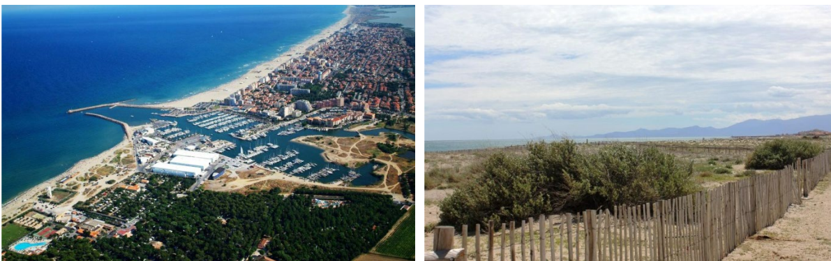
Figure 63 : Digue portuaire à Canet / Ganivelles au Barcarès.
